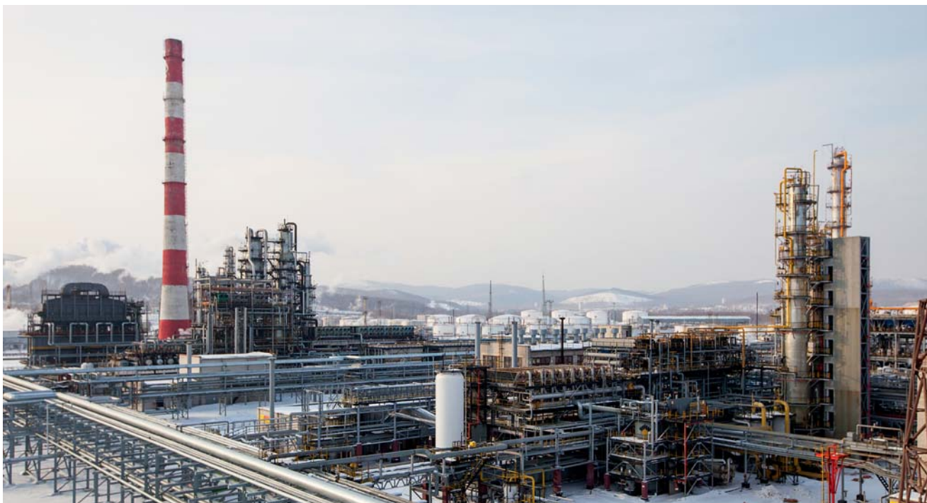
Установка каталитического риформинга на Комсомольском НПЗ
